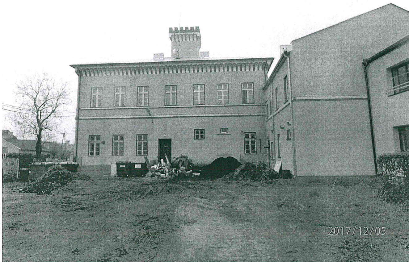
Elewacja od strony ogrodu.
