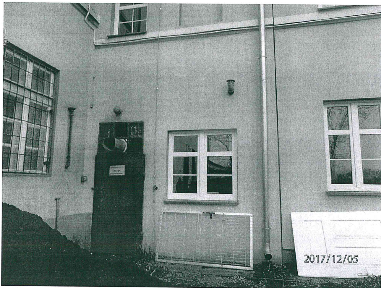
Wejście zewnętrzne do kotłowni od strony ogrodu.
