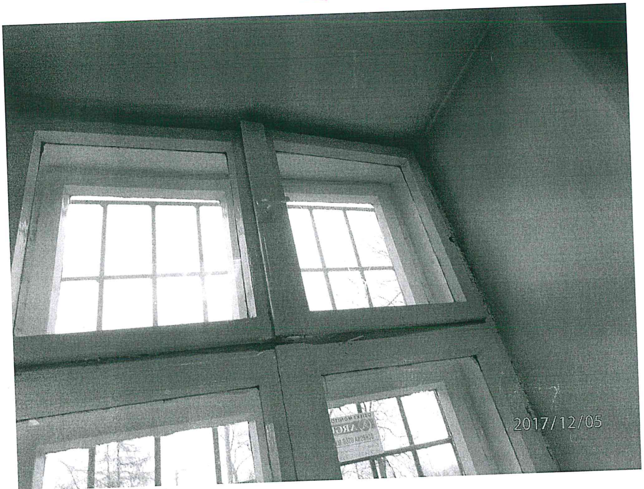
Okno w klatce schodowej
